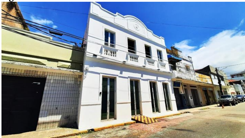
Figura 1 – Fachada da Casa da Ribeira
