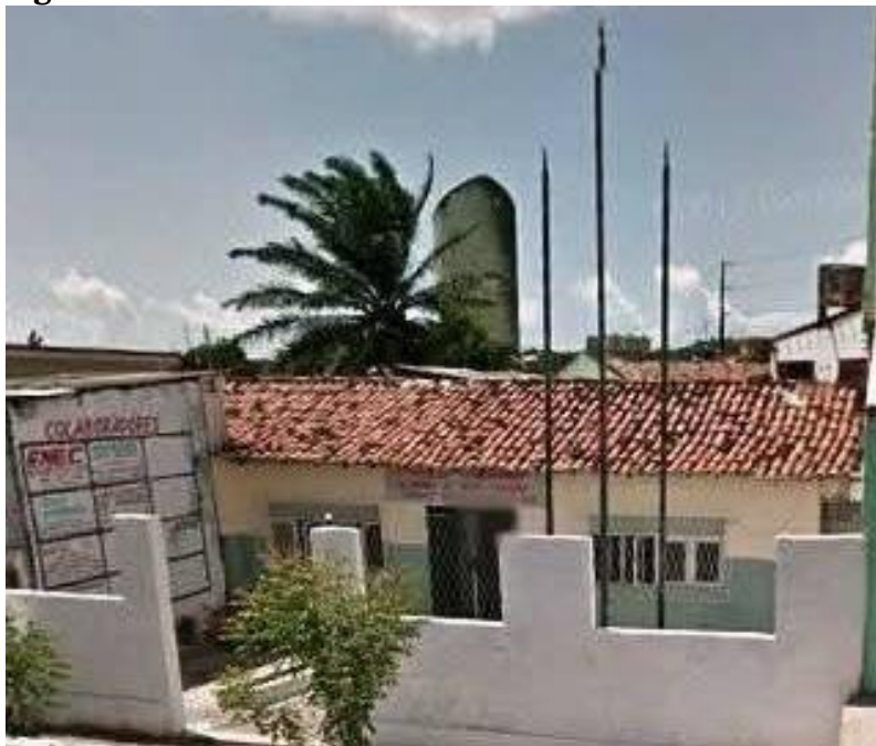
Figura 1 – Fachada do centro comunitário
