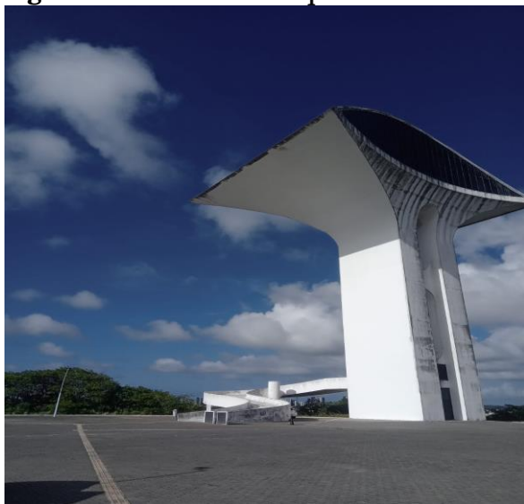
Figura 1 – Fachada do Parque da Cidade de Natal/RN
