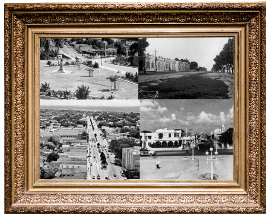
Figura 12- Natal do Grande Ponto e da mítica Avenida Deodoro
